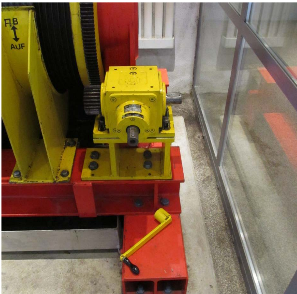
Abb. 11: Handkurbel, mit der man den Aufzug manuell bewegen kann. Das kleine Getriebe kann dafür zum Zahnkranz des Motors verschoben werden.
